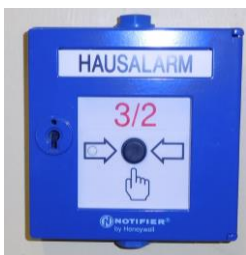
Druckknopfmelder für den Feueralarm
